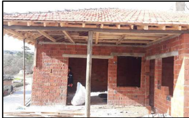
Karabeyler Mahallesinde Yeni Yapılan Muhtarlık Binasına Elektrik Tesisatı Yapıldı
